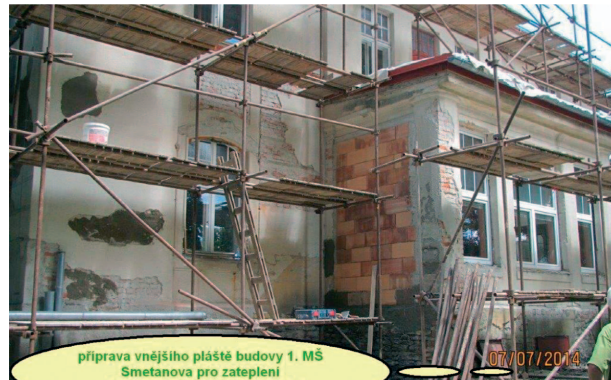
O kus dál se připravuje budova mateřské školy k zateplení a posledním úpravám
