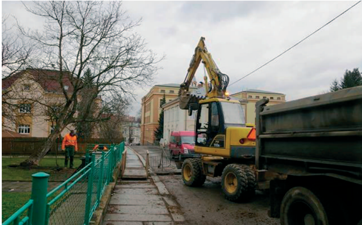
Výstavba kanalizace v zimě pokračovala
