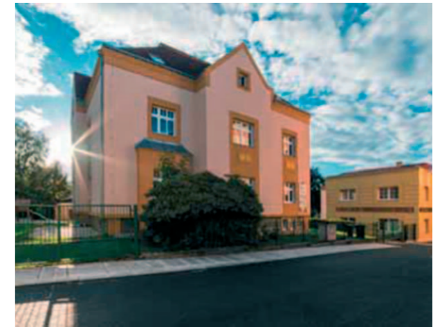
Školní jídelna a školní družina po rekonstrukci
