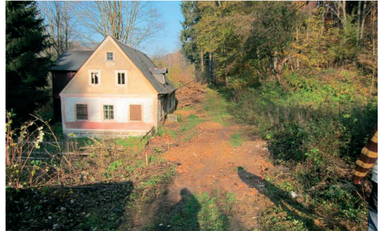
Technické služby opravují místní komunikaci v Dlouhém Dolu. Pro porovnání 3 roky starý snímek. Dům je také opraven...
