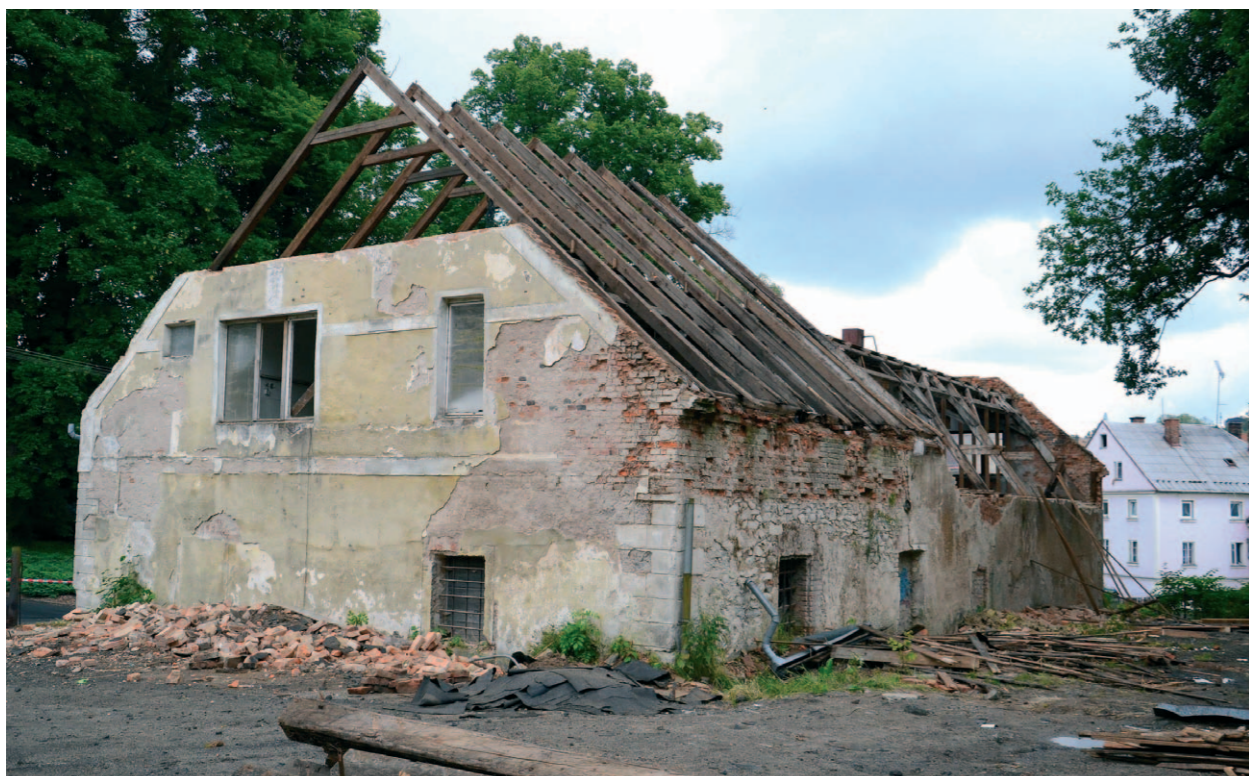
Tady se rozebírá budova někdejší hasičské zbrojnice
