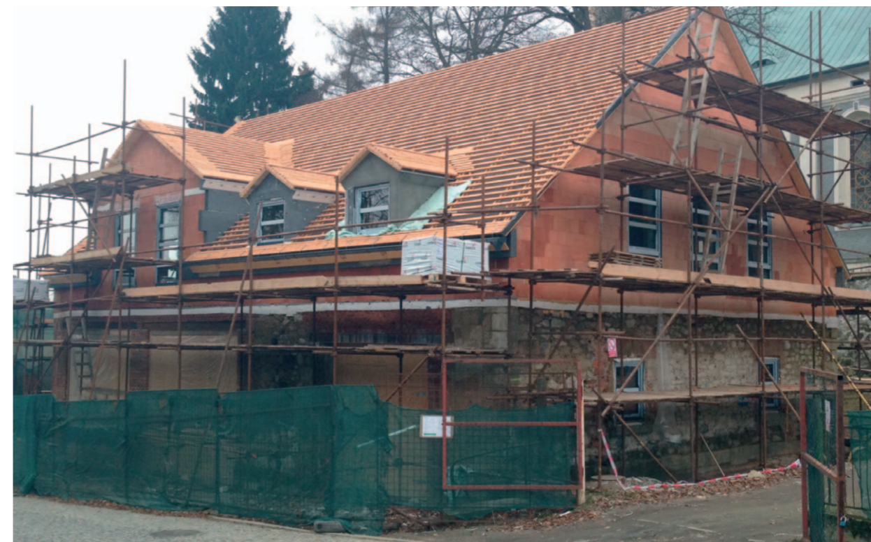
Pohled na stavbu hasičské zbrojnice v listopadu 2014
