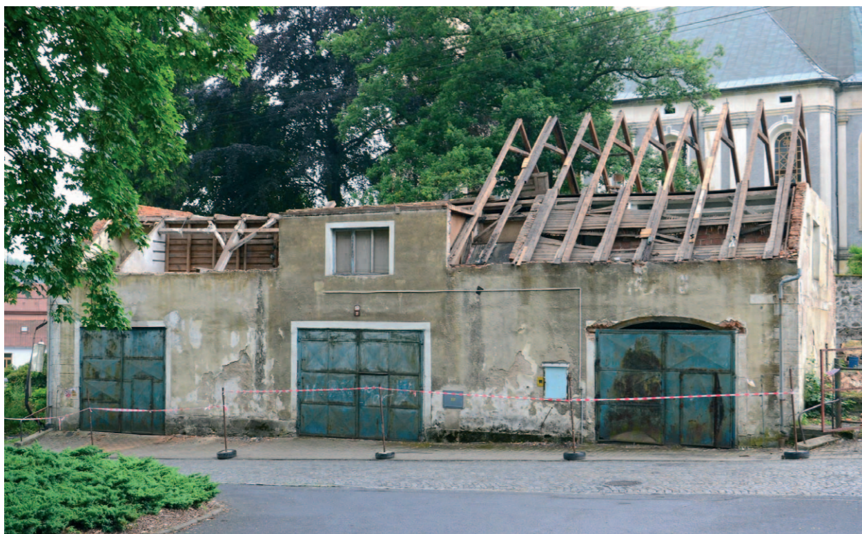
Tady se rozebírá budova někdejší hasičské zbrojnice
