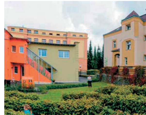
Školní jídelna a školní družina po rekonstrukci
