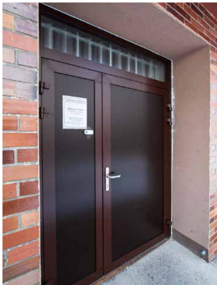
Výměnou vstupních dveří jsme dokončili opravu domu služeb
