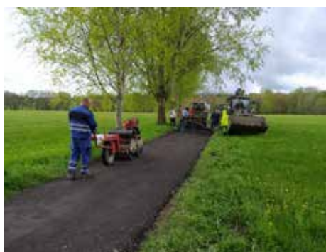
S využitím asfaltového recyklátu jsme svépomocí opět opravili řadu vedlejších místních komunikací
