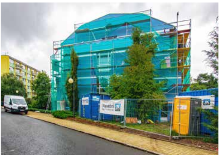
S využitím evropských dotací jsme snížili energetickou náročnost (výměna oken a zateplení fasády) domu se sociální službou I v Nemocniční ulici
