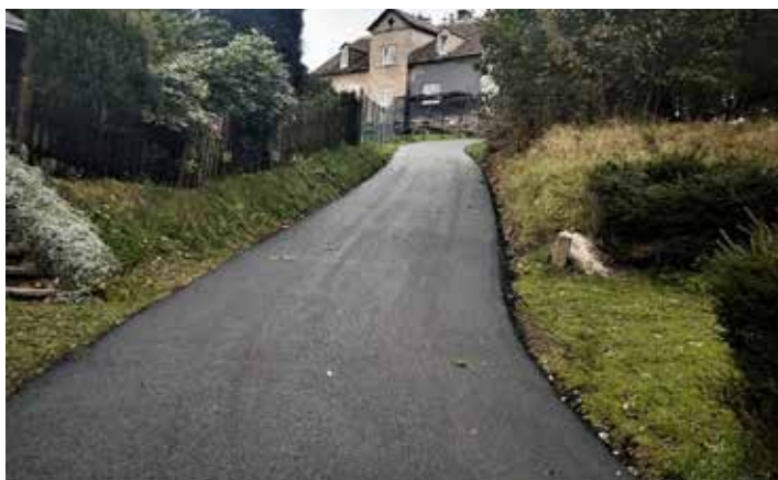
Asfaltobetonový povrch dostaly komunikace v ulici Polní, Jugoslávská a Pod Lipou
