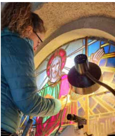
Proběhla oprava vitráží v rodinné hrobce Johanna Nitsche na hřbitově ve Vlčí Hoře
